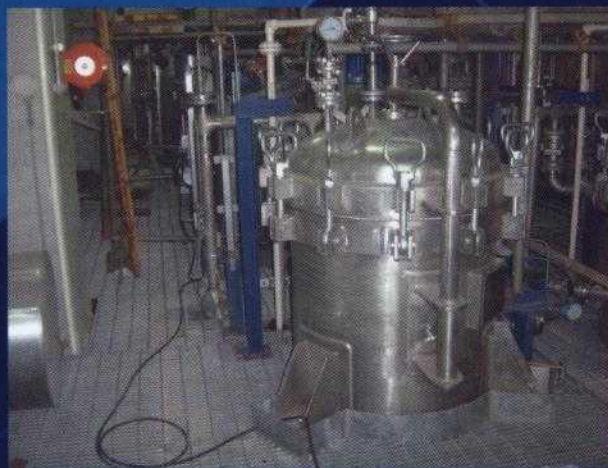
Установка импульсного свечного фильтра Sharplex на заводе Ciba Speciality в Сингапуре
